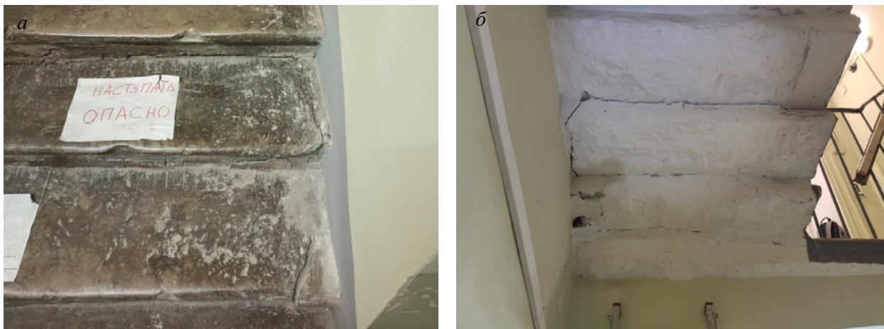
Рис. 14. Излом двух нижних ступеней марша от локальной перегрузки в Здании театрального декорационного зала и экипажного заведения, Б. Подъячская, д. 20:
