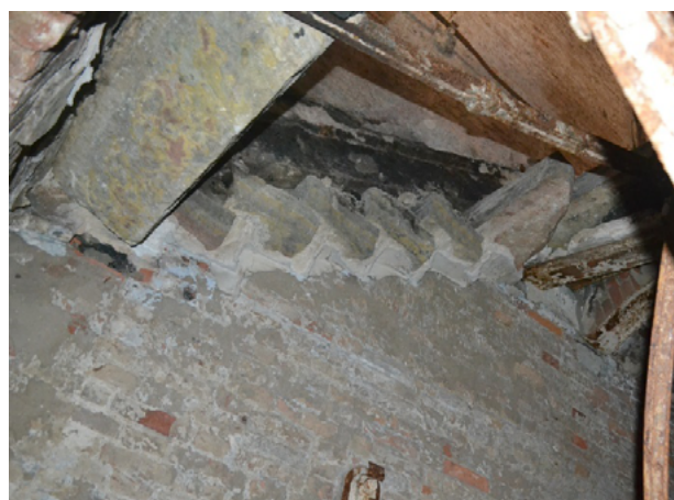
Рис. 16. Обрушение известняковых ступеней при пожаре. Лестница по косоурам постройки 1850-х гг. в Санкт-Петербурге (фото выполнено авторами, 2022)
